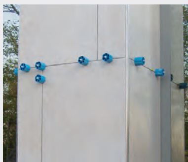
Roteando el tirante se pueden nivelar espesores hasta 40 mm con fuga de 8 mm
