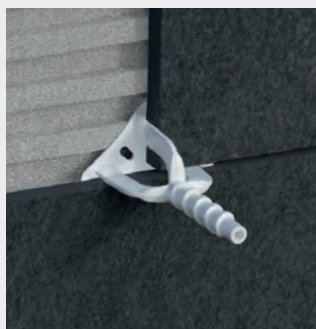
Colocación de nivelador en media cruz
