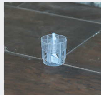
Colocación de nivelador lineal
