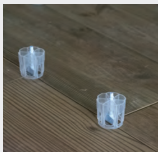
Colocación de nivelador en media cruz
