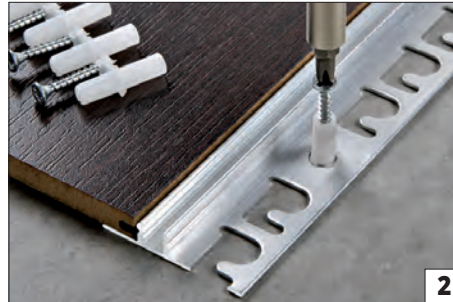
2) Atornillar o fijar con adhesivo la base al pavimento.
