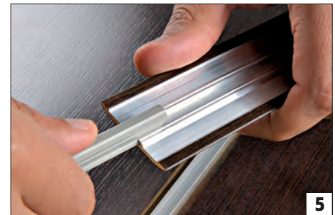
5) Insertar el perfil de PVC en el perfil de aluminio de arriba a abajo (si la inserción es difícil, lubricar con agua, silicona spray o aceite vegetal).
