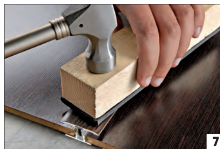
7) Utilizando un listón de madera y un martillo, preionar con uniformidad a todo lo largo del perfil. Al golpear correctamente se tiene que oír un "click". Significa que el perfil ha encajado correctamente en la base de aluminio.
